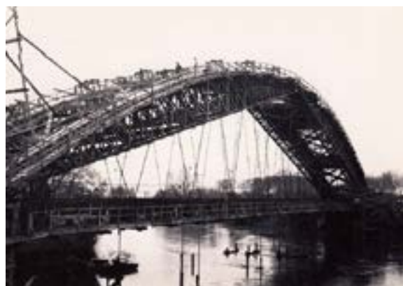
En haut, le pont de la Coudette en construction et à gauche, en service en 1943. En amont, on distingue encore les haubans de l'ancien pont suspendu qui est en cours de démolition.
