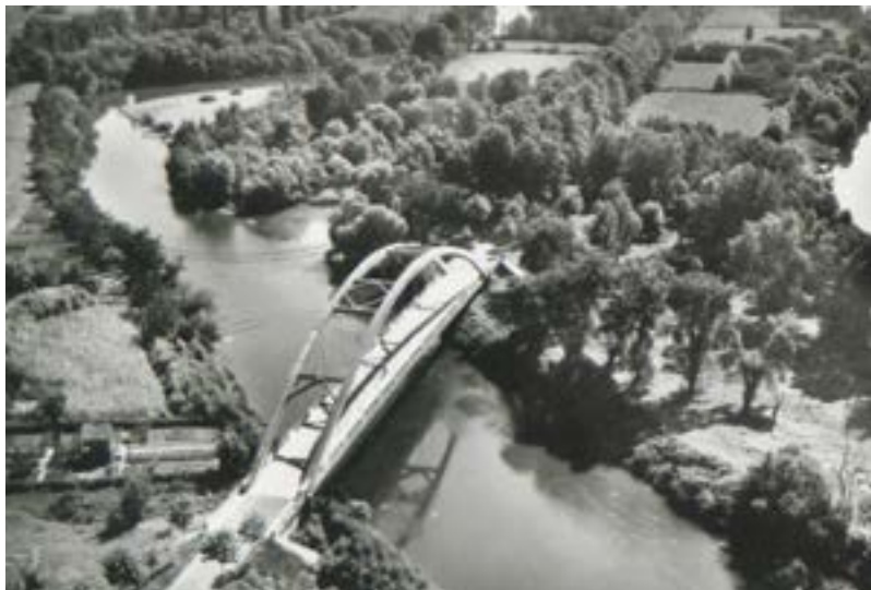
En haut, le pont de la Coudette en construction et à gauche, en service en 1943. En amont, on distingue encore les haubans de l'ancien pont suspendu qui est en cours de démolition.
