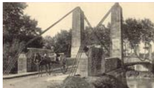
L'ancien pont suspendu
