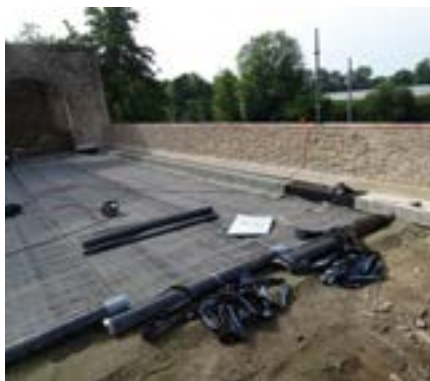
Travaux pour assurer l'étanchéité de la terrasse © CCPOA
