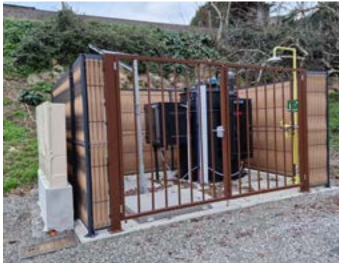
Le nouveau poste de relevage sur le chemin du Lavoir
