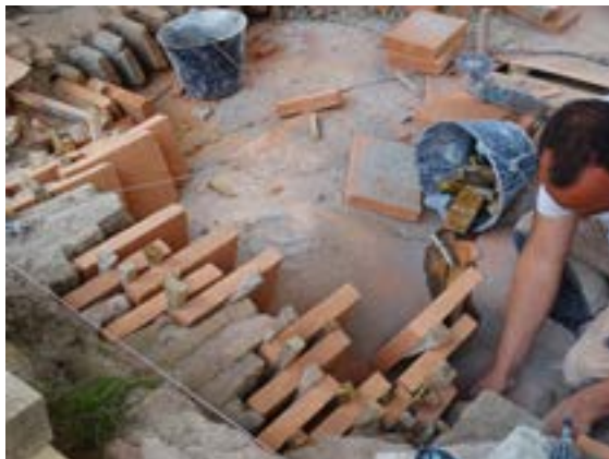
Reconstruction d'une voûte d'arêtes en brique dans les règles de l'art © CCPOA
