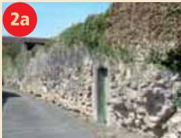
**2a** Le rempart encerclait le village dès le XIII<sup>ème</sup> s ; cette enceinte fortifiée constituée de gros moellons de galets à sa base et d'un moyen appareil en hauteur, mesurait plus d'1m d'épaisseur pour une hauteur de près de 5m.
